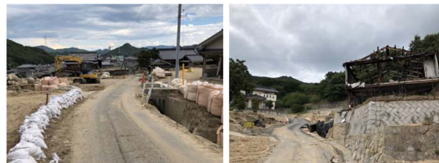
大雨による土砂崩れ被害の様子(福地サテライト付近)
